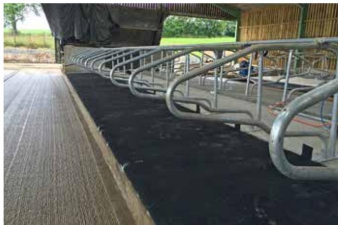
Le support doit avoir été coulé depuis au moins 28 jours et il ne doit pas y avoir de laitance (qui pourrait provoquer une réaction chimique avec le caoutchouc et provoquer une usure prématurée). Avant la pose, nettoyer le support et le laisser sécher.
